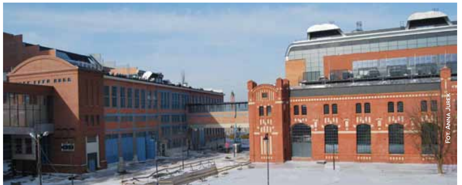
CZĘŚĆ REMONTOWANEGO OBIEKTU EC1.
